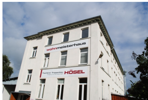
Tischlerei und Treppenbau Hösel im
